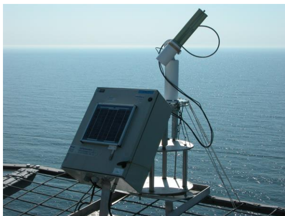
Radiometru oceanic instalat la Platforma “Sectia 7”
